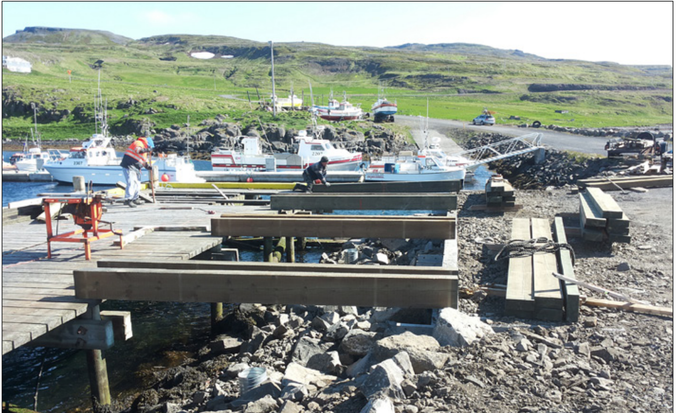
Drangnes, trébryggja í Kakkálsvík, endurbýgging (12 m) í júlí 2015. Sjá kort yfir framkvæmdir á siglingasviði í miðopnu, bls. 8-9.
